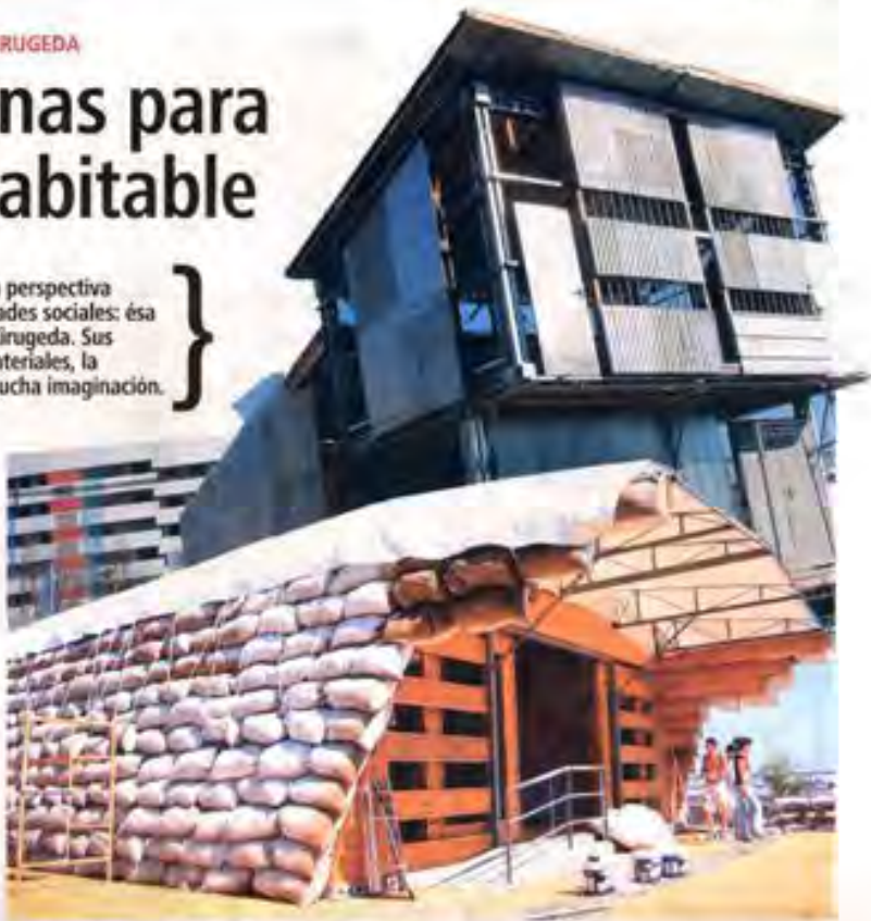
BIENO, BONO Y BARATO. Cirugeda desarrolla viviendas, como las que se ven arriba, aprovechando desperdicios y materiales para construcción.
