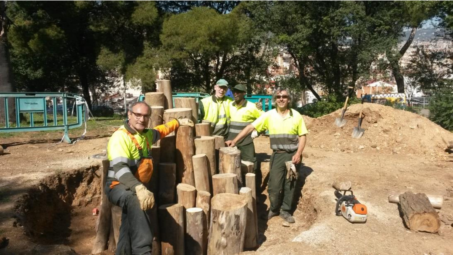
Construction of wooden pyramid in El Polvorí, Montjuïc
